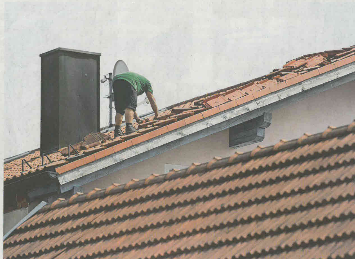
Hausbesitzer sollten das Dach prüfen – denn Stürme oder Gewitter können größere Schäden verursachen. Sind Reparaturen notwendig, sollten sie von Fachleuten erledigt werden, raten Experten. Foto: Sven Hoppe/dpa/dpa-tmn
