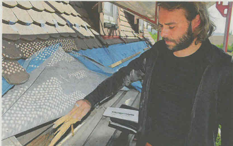
Unter den Händen des Gebäudemangers Stefan Fuchs zerbröseln die vermoderten Holz von neun Deckenbalken im Eschenauer Rathaus.
